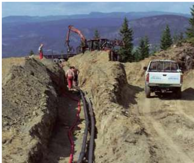
Bild 12. Nedgrävning av rör på frostfritt djup.
